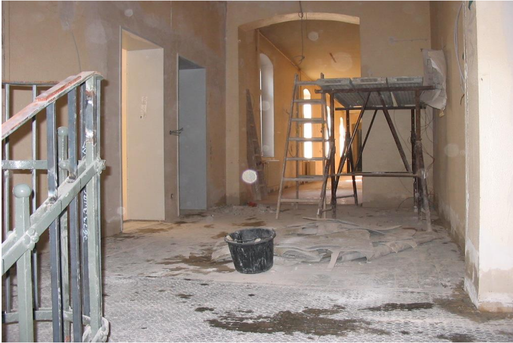
Alle Türen werden auf Normgröße gebracht, die Flure werden zum Teil vergrößert, aber auch an notwendigen Stellen mit neuen Zwischenwänden versehen.
