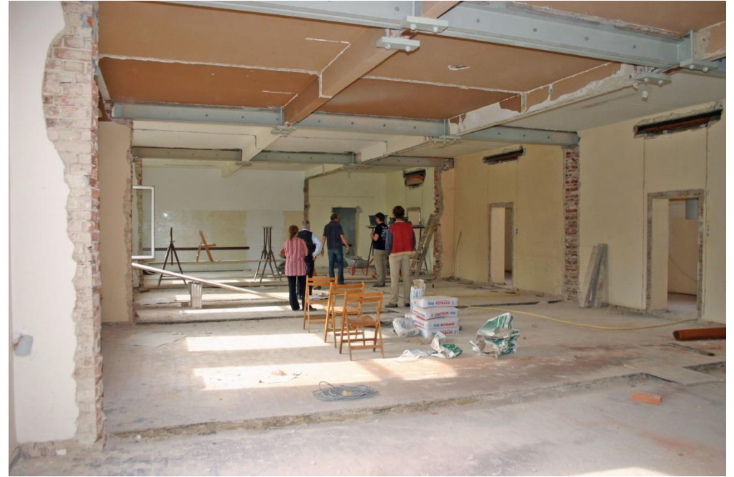
Die Arbeiten schreiten zügig voran. Die Höhe der Bühne wird geplant. Die statische Verbindung von Alt und Neu ist gelungen.
