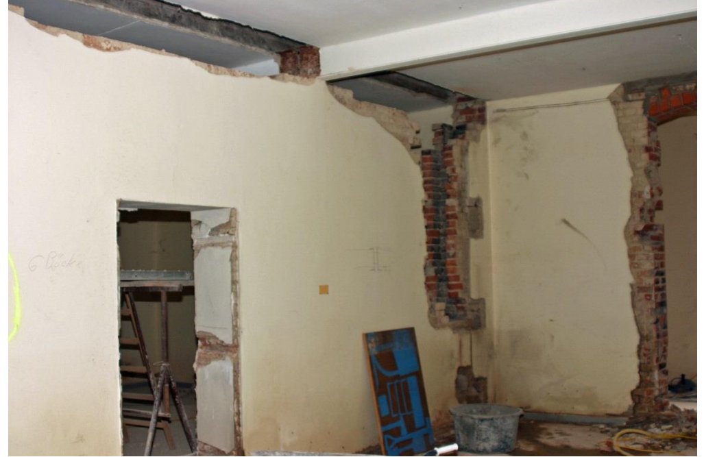
Zwischenwände wurden abgerissen, Türen zugemauert oder vergrößert und Decken verstärkt . Hier hat man den „Durchblick“ vom Erdgeschoss in die 1. Etage
