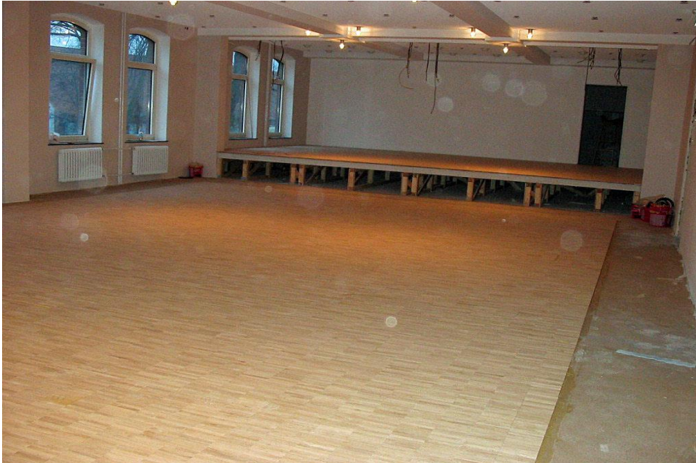
Der Holzboden wird verlegt und bekommt den letzten Schliff
