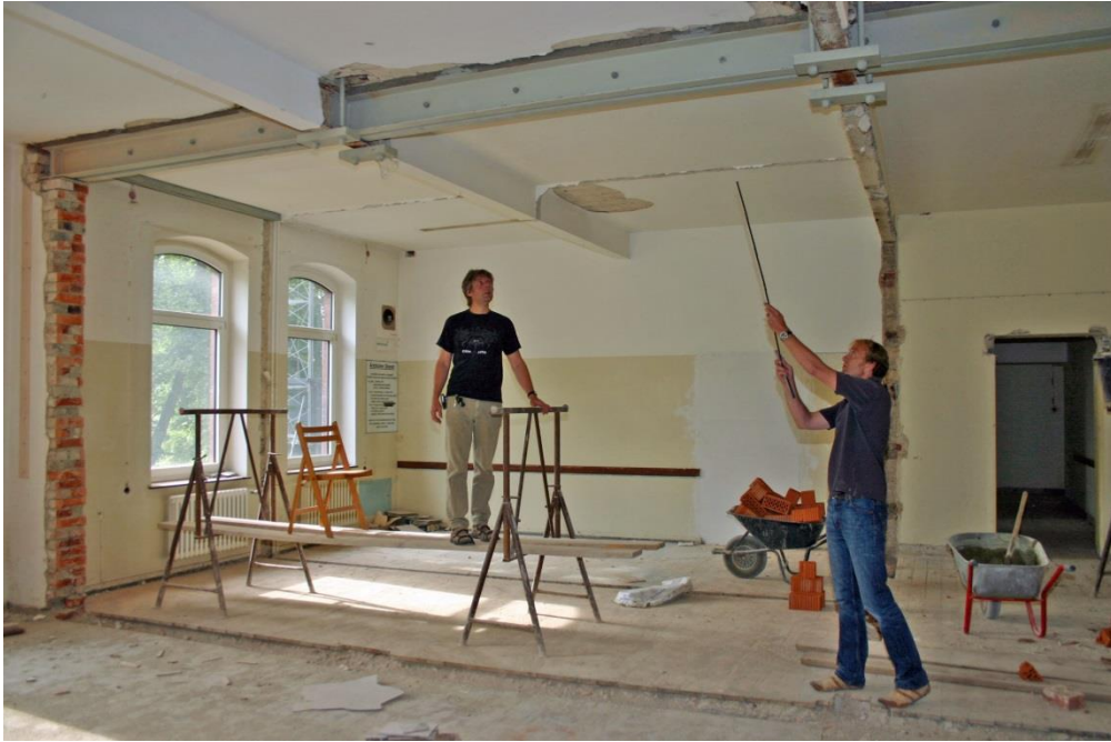
Die Arbeiten schreiten zügig voran. Die Höhe der Bühne wird geplant. Die statische Verbindung von Alt und Neu ist gelungen.
