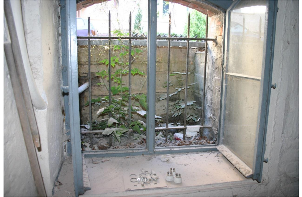
Zugewachsene Kellerfenster wurden freigelegt, feuchte Wände gesandstrahlt und Räume mit neuen Böden versehen.
