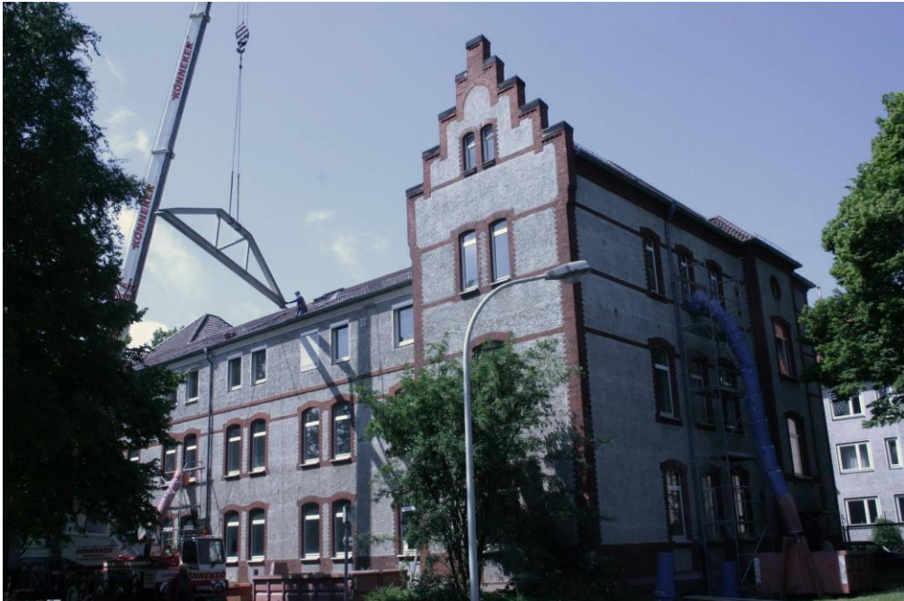
Stahlträger für den Kleinen Saal und für die Dachkonstruktion zur Sicherung des Konzertsalles werden geliefert.
