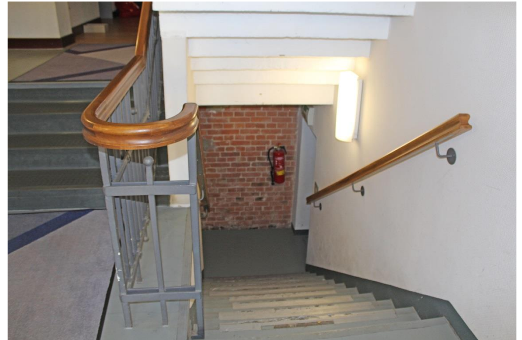
und der Treppenabgang zu den Keller- und Schlagzeugräumen.
