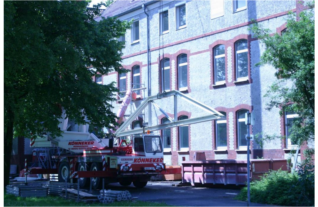
Stahlträger für den Kleinen Saal und für die Dachkonstruktion zur Sicherung des Konzertsalles werden geliefert.
