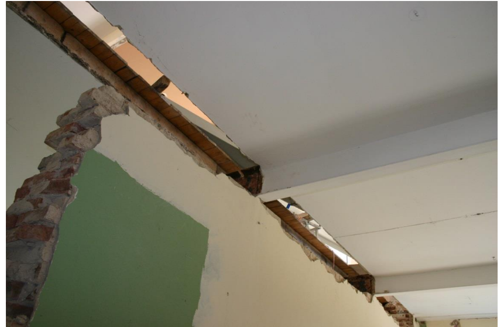
Zwischenwände wurden abgerissen, Türen zugemauert oder vergrößert und Decken verstärkt . Hier hat man den „Durchblick“ vom Erdgeschoss in die 1. Etage
