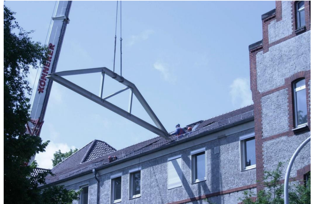
Stahlträger für den Kleinen Saal und für die Dachkonstruktion zur Sicherung des Konzertsalles werden geliefert.
