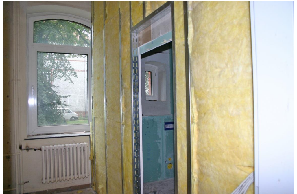
Alle Türen werden auf Normgröße gebracht, die Flure werden zum Teil vergrößert, aber auch an notwendigen Stellen mit neuen Zwischenwänden versehen.
