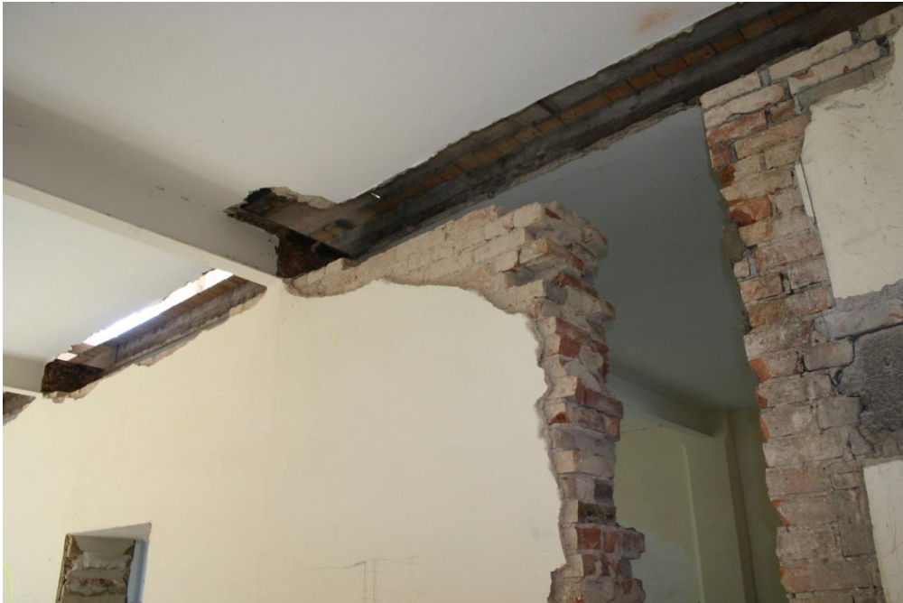
Zwischenwände wurden abgerissen, Türen zugemauert oder vergrößert und Decken verstärkt . Hier hat man den „Durchblick“ vom Erdgeschoss in die 1. Etage
