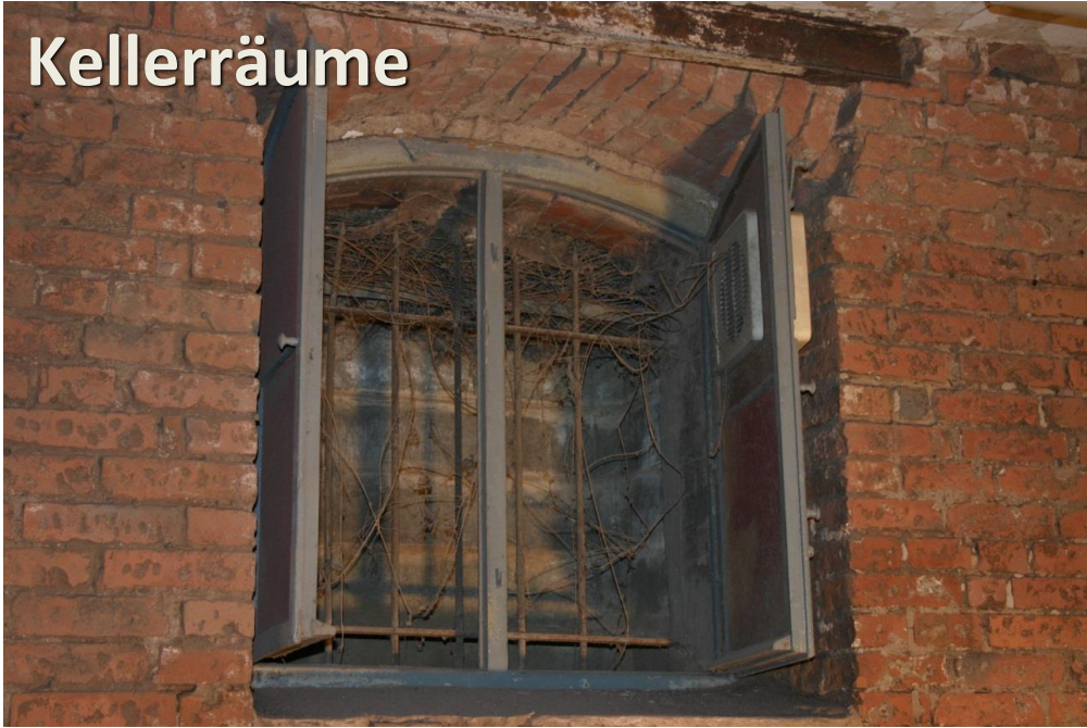
Zugewachsene Kellerfenster wurden freigelegt, feuchte Wände gesandstrahlt und Räume mit neuen Böden versehen.
