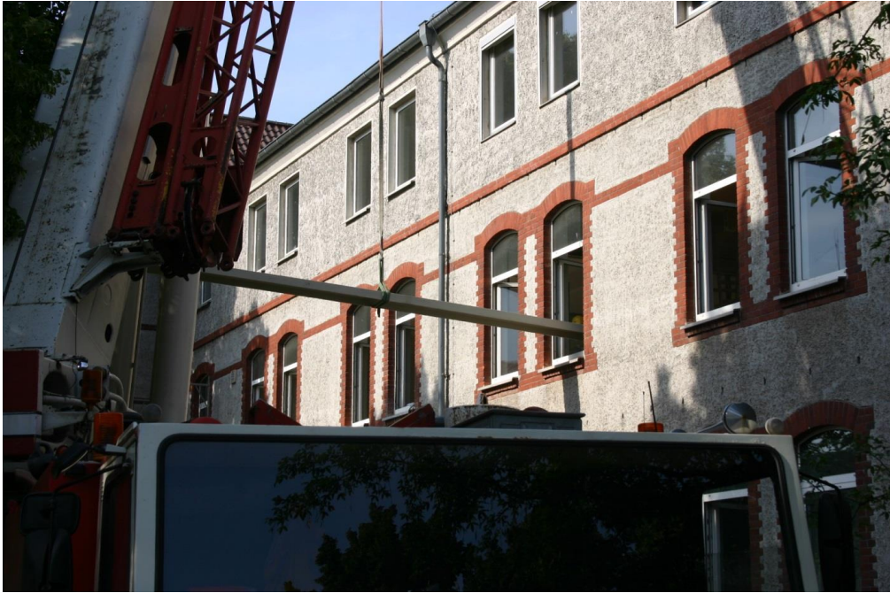
Stahlträger für den Kleinen Saal und für die Dachkonstruktion zur Sicherung des Konzertsalles werden geliefert.
