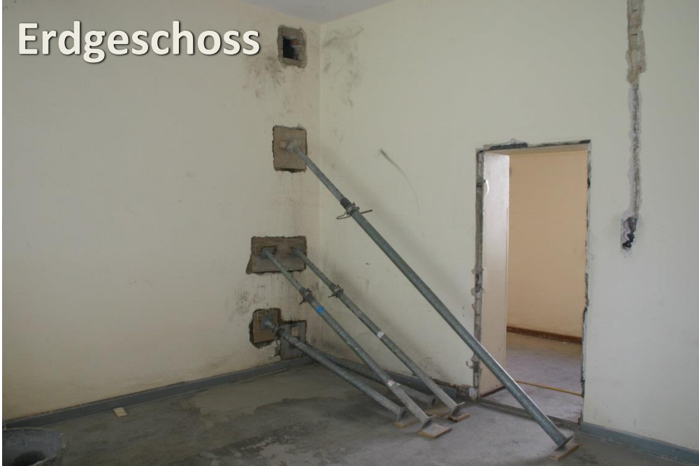
Zwischenwände wurden abgerissen, Türen zugemauert oder vergrößert und Decken verstärkt . Hier hat man den „Durchblick“ vom Erdgeschoss in die 1. Etage
